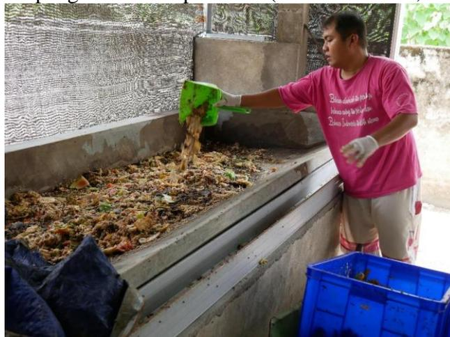
**Gambar 7. Pemasukan sampah ke Bioreaktor**
