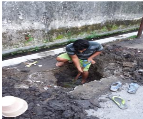
Gambar10. Perbaikan Pipa Induk
