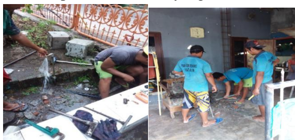
Gambar9. Perbaikan Kebocoran Pipa Konsumen
